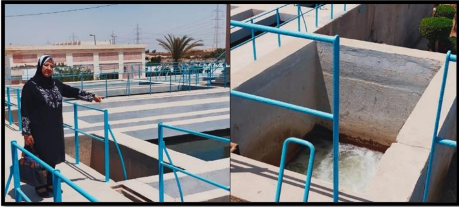
صورة (٩) أحواض الترويب بمحطة مياه السادس من أكتوبر القديمة
