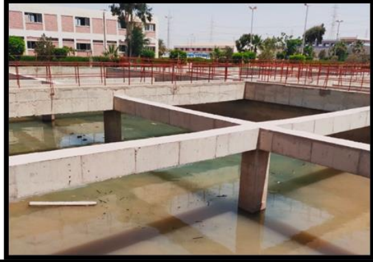
صورة (١٥) أحواض المياه العكرة بعد الترشيح بمحطة تنقية مياه السادس من أكتوبر القديمة
