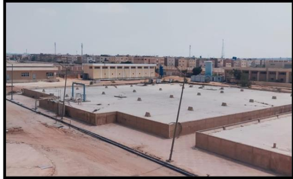
صورة (٣٠) خزان المياه المرشحة في محطة تنقية مياه الشرب بمدينة العبور
