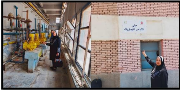
صورة (٨) مبني الشبه والكيماويات بمحطة مياه السادس من أكتوبر القديمة
