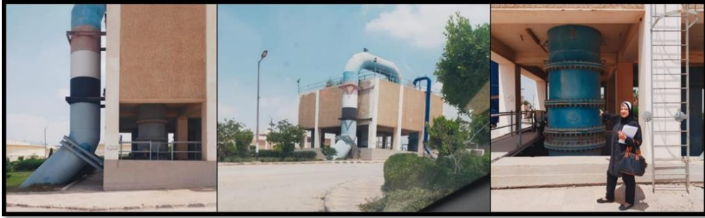
صورة (٢٤) موزع المياه العكرة لمحطة تنقية مياه الشرب بمدينة العبور
