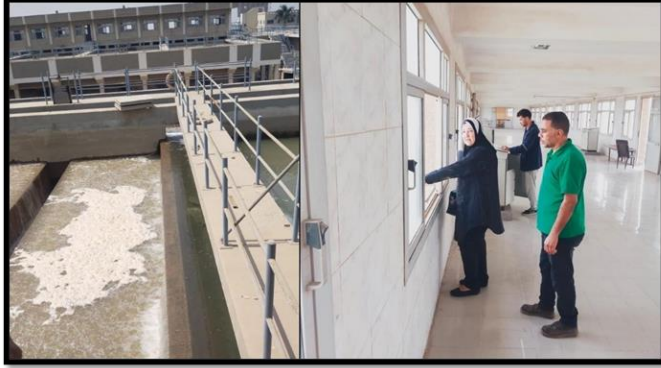
صورة (٢٩) المرشحات في محطة تنقية مياه الشرب بمدينة العبور
