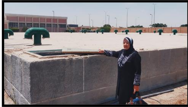
صورة (٧) بئر التوزيع للمياه النقية بمحطة مياه السادس من أكتوبر القديمة
