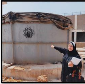
صورة (٣٢) خزانات الشبة في محطة تنقية مياه الشرب بمدينة العبور
