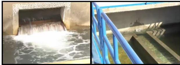
صورة (١١) مرحلة الكلورة بمحطة مياه السادس من أكتوبر القديمة
