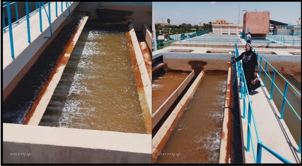
صورة (١٠) المرشحات بمحطة مياه السادس من أكتوبر القديمة
