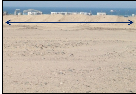
صورة (١٠) : السدود الرملية التى تستخدمها شركة بترول خليج السويس للمحماية من تهديد السيول بمنطقة الدراسة.
