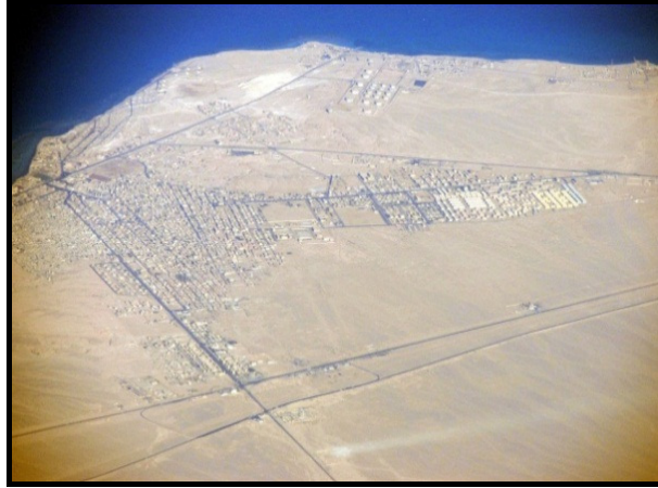
شكل (١٣) : صورة جوية لمدينة رأس غارب التى تأثرت بسيول ٢٠١٦م وتوضح الطرق والعمران الذى تأثر بشكل شديد جداً.
