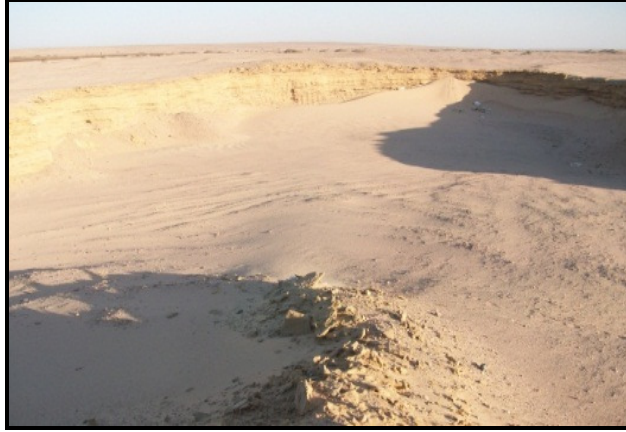
صورة (١١) : حفر تجميع مياه السيول كأحد طرق الحماية بحوض وادي أبوحد بمنطقة الدراسة.
