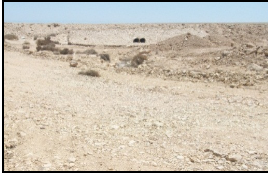
صورة (٩) : المواسير أحد أشكال المعابر الأرضية أسفل الطرق بمنطقة الدراسة.
