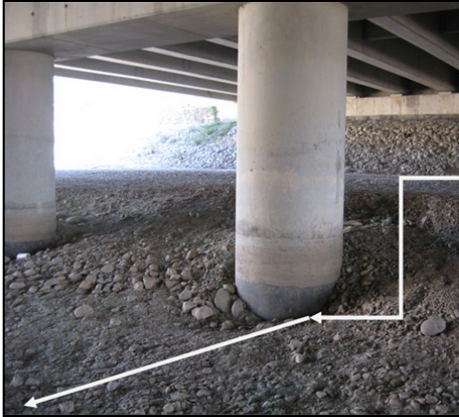
شكل (١٦) : مستوى النحر كما تبينه قواعد الجسر.
