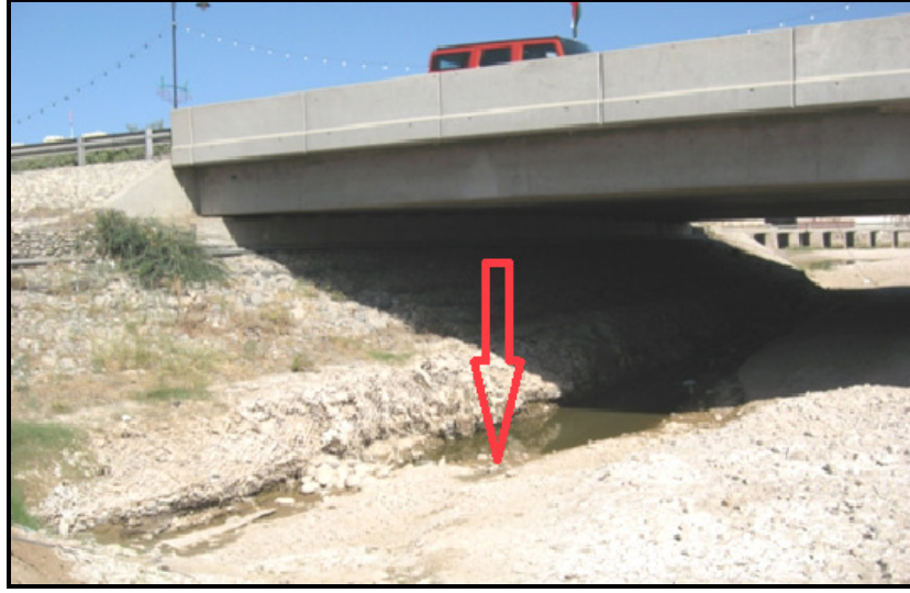
شكل (١٧) : انكشاف طبقة الأساس على الجانب الذي تعرض للنحر .
