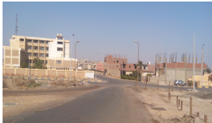
صورة (٢٠) : الحد الفاصل بين أراضي الشركة العامة للبترول بمدينة رأس غارب (دراسة ميدانية ابريل ٢٠١٦م).
