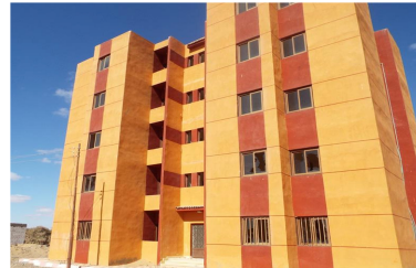
صورة (١٩) : عمارة سكنية بقرية طبل آمون (دراسة ميدانية أغسطس ٢٠١٦م).
