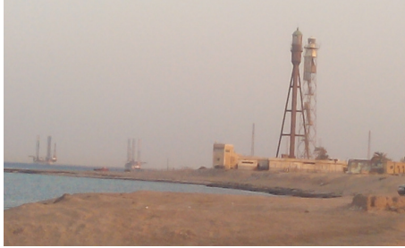
صورة (٦) : فناء ميناء بترول رأس غارب وتظهر المنصات البحرية لاستخراج البترول (دراسة ميدانية ابريل ٢٠١٦م).
