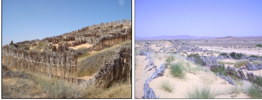
صورة (٦، ٧) : التثبيت الميكانيكي والدور الذي لعبه سعف النخيل كمصدات للرياح.
